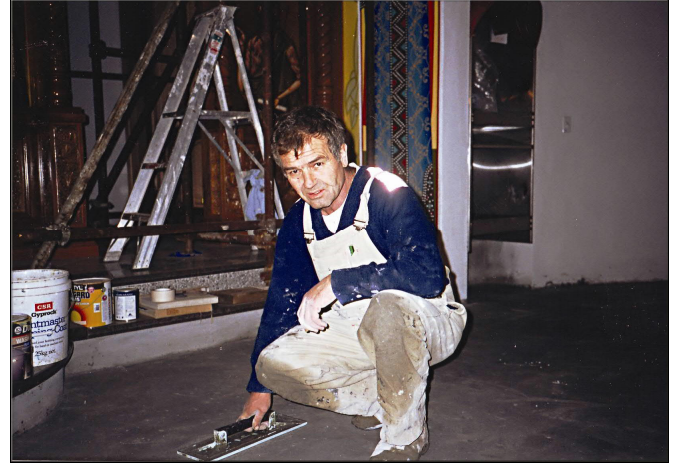
Уређење и постављање пода у цркви (1998.)
